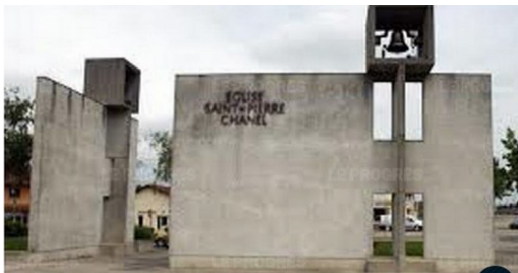
L'architecture de l'église a été, au début, très controversée. Photo Karen CHEVALIER
